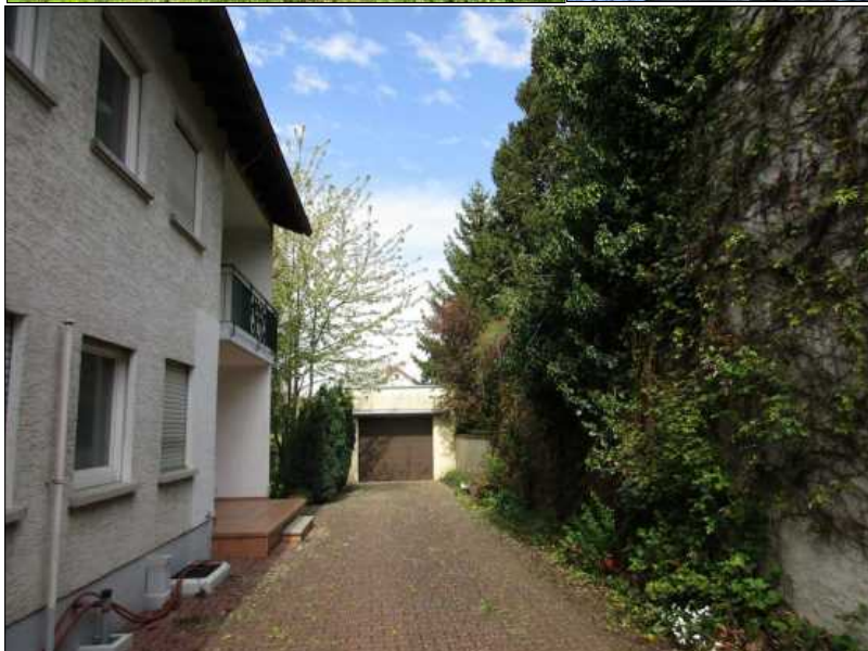
Foto 7: Dichte Berankung wie hier mit Efeu an der Rückwand der "Alten Schule", kann als Nistplatz von machen Vögeln genutzt werden. 12.04.17-HGF
