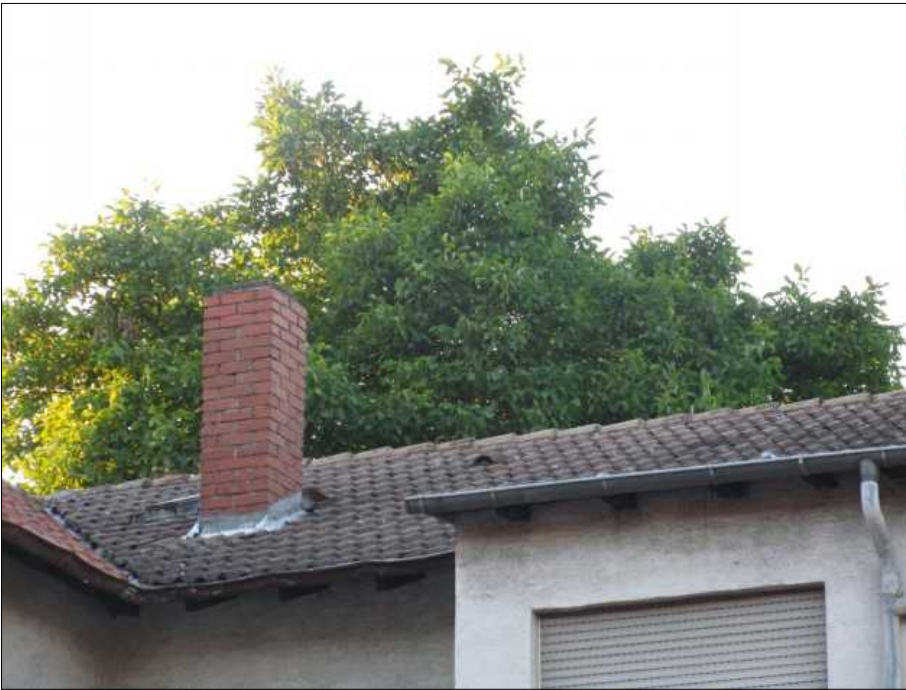
Foto 1: Der vordere Nußbaum überragt weit das Abrißgebäude der alten Metzgerei. Leider ist er nicht zu erhalten. Blick aus dem Hof nach Nord. 14.06.17-HGF
